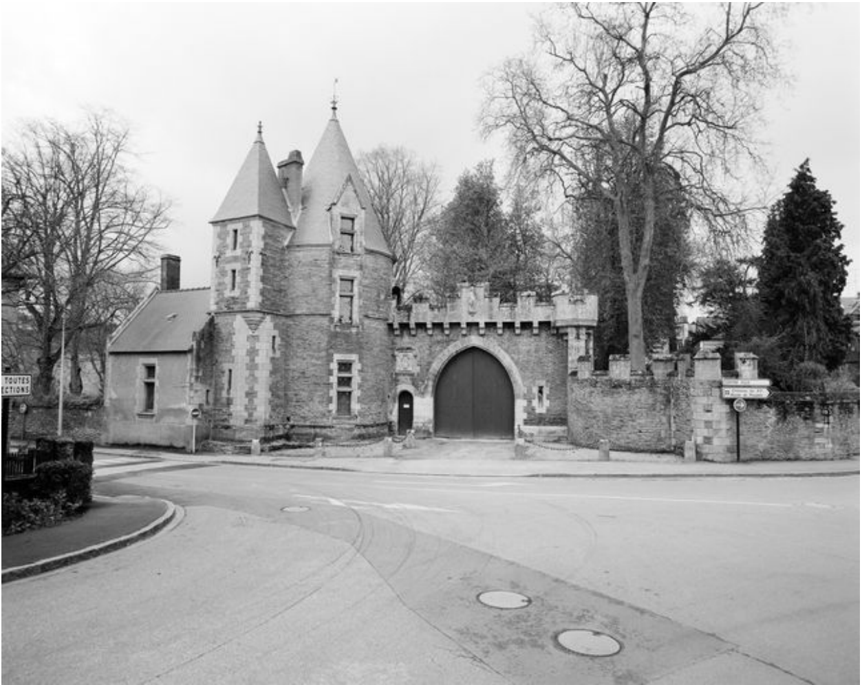
Porterie du château : vue générale nord
