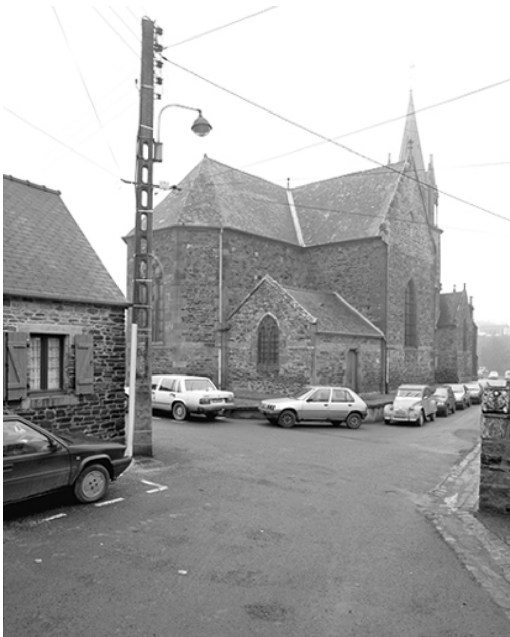
Vue générale nord-est
