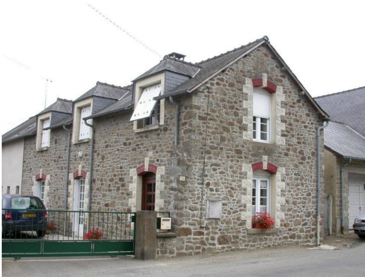
Vue générale soud-ouest
