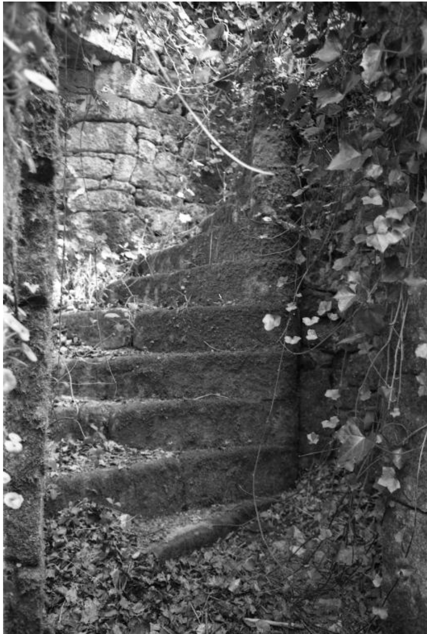
Ruines de l'ancien château - Vue de l'intérieur, escalier
