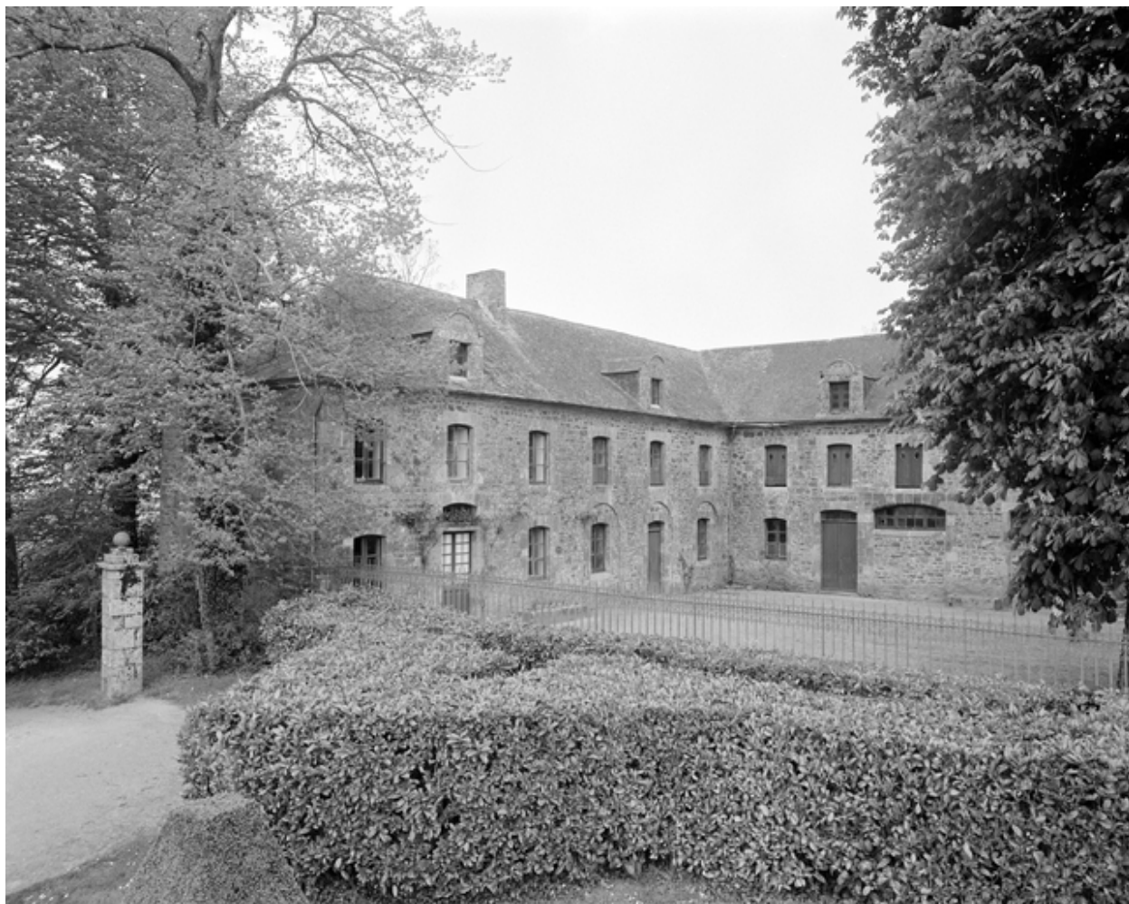
Dépendances : vue générale sud
