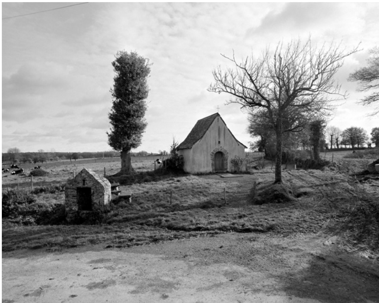
Elévation Ouest : vue de situation
