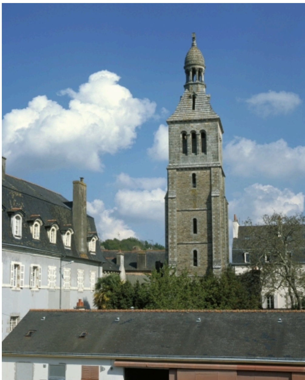
Clocher isolé, élévation sud
