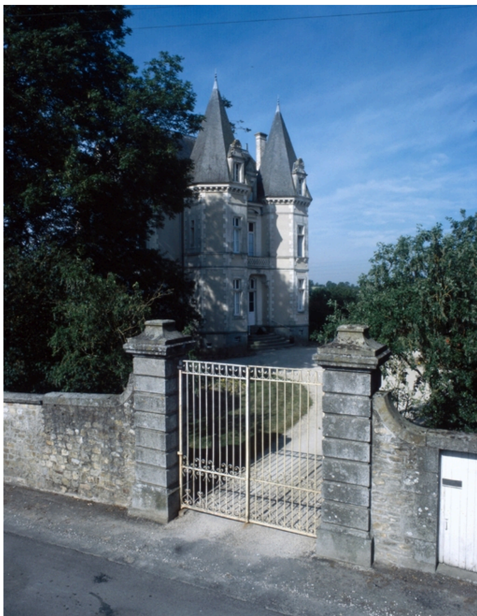
Vue générale de la façade latérale.
