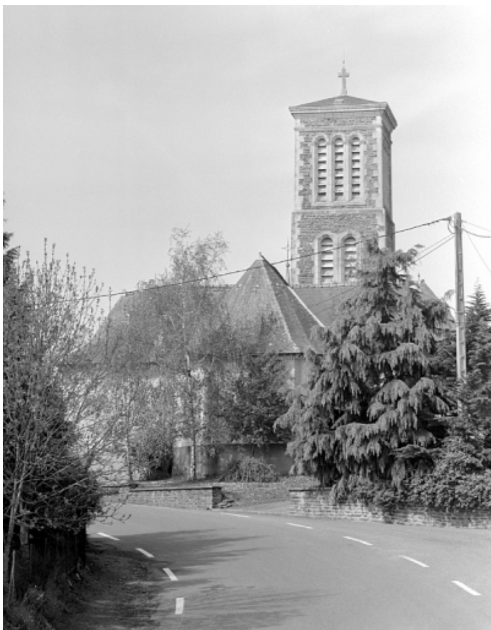
Vue générale est
