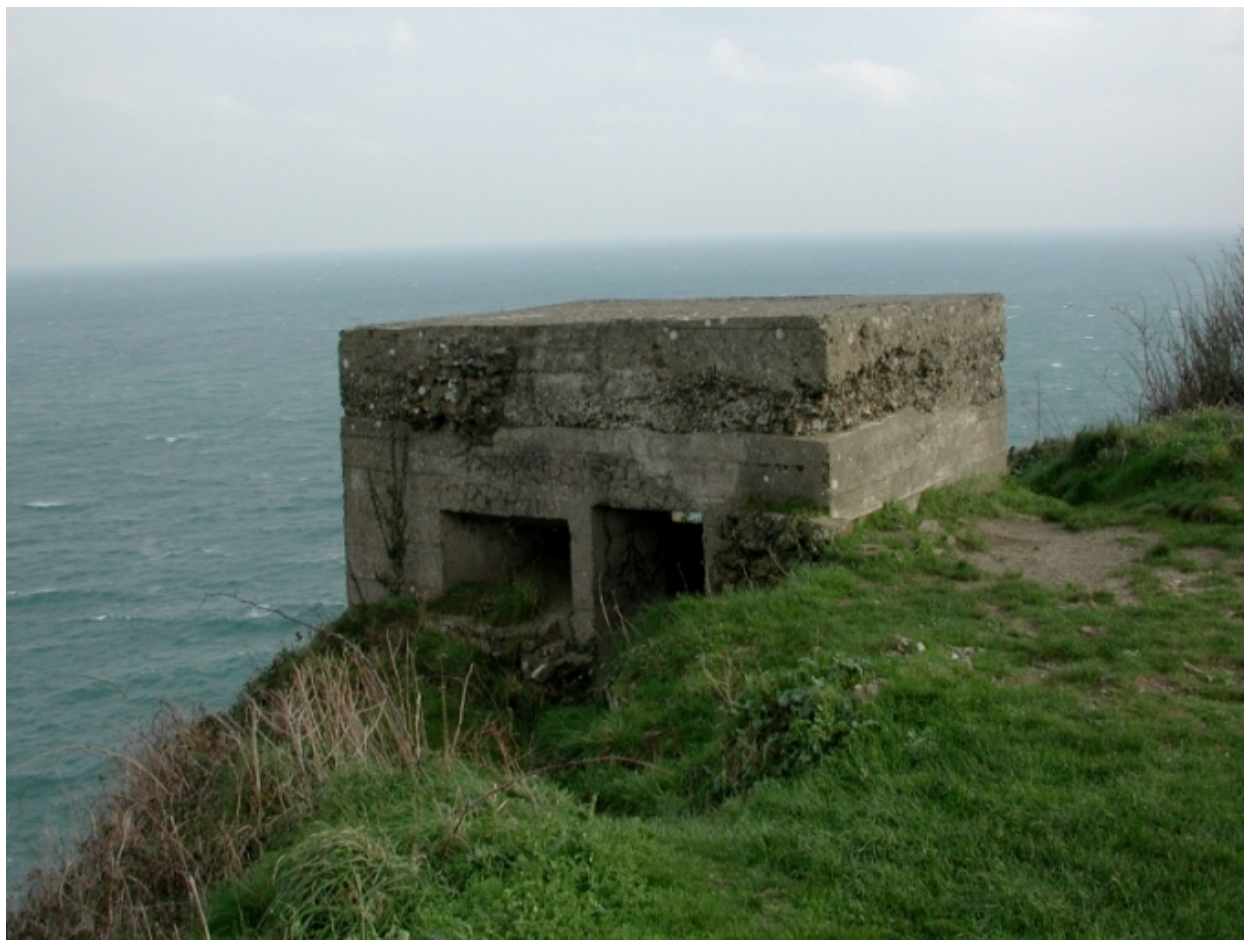
Vue générale du blockhaus côté ouest
