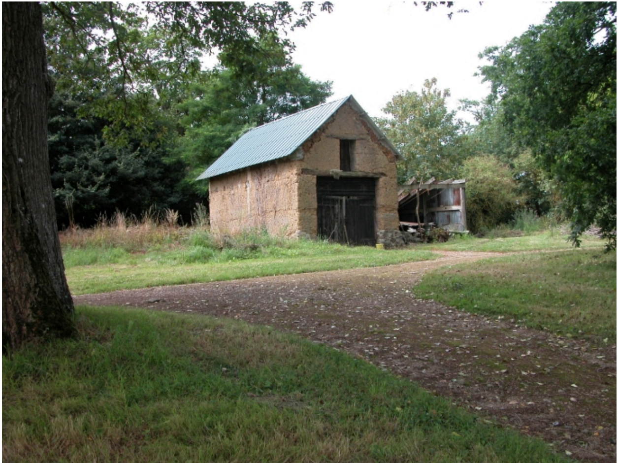
Ferme située à l'ouest, la grange
