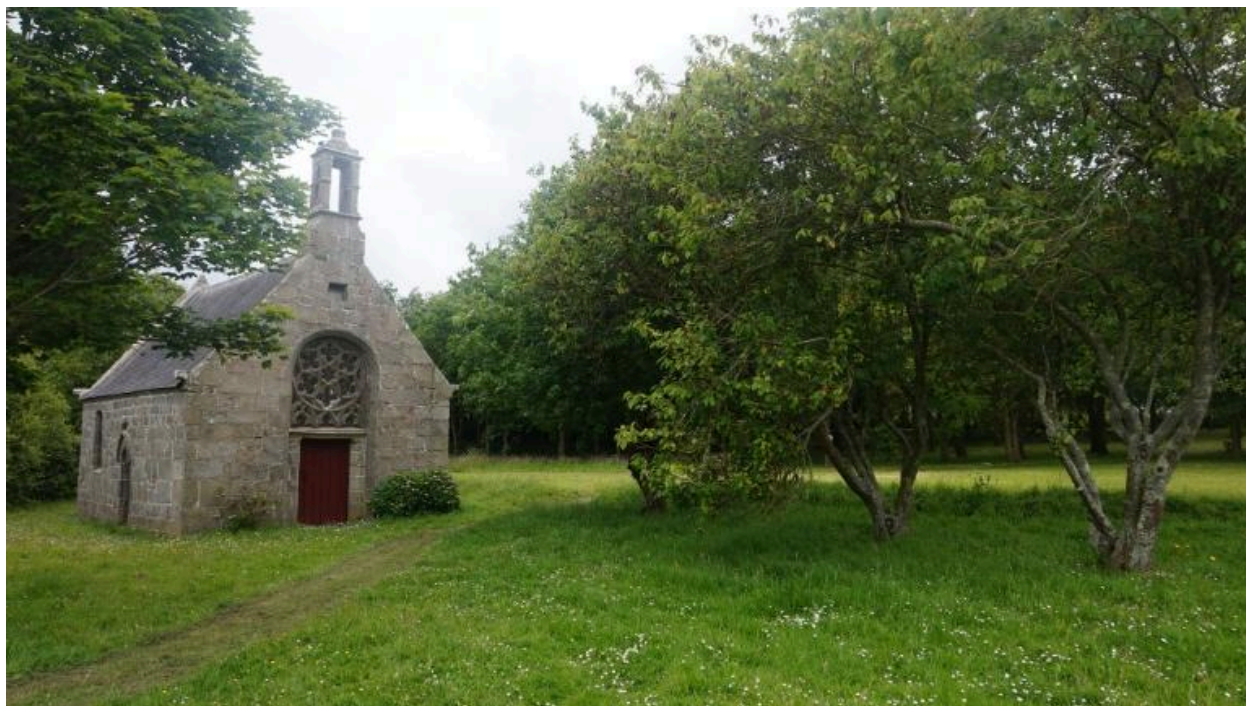
Vallon de Troménec : aménagements et chapelle
