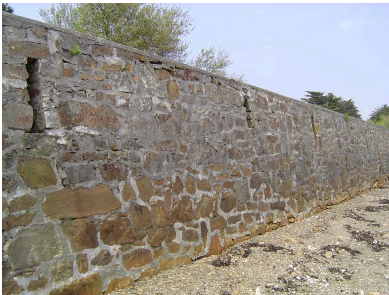
Vue générale de la digue de l'anse de l'Île Longue
