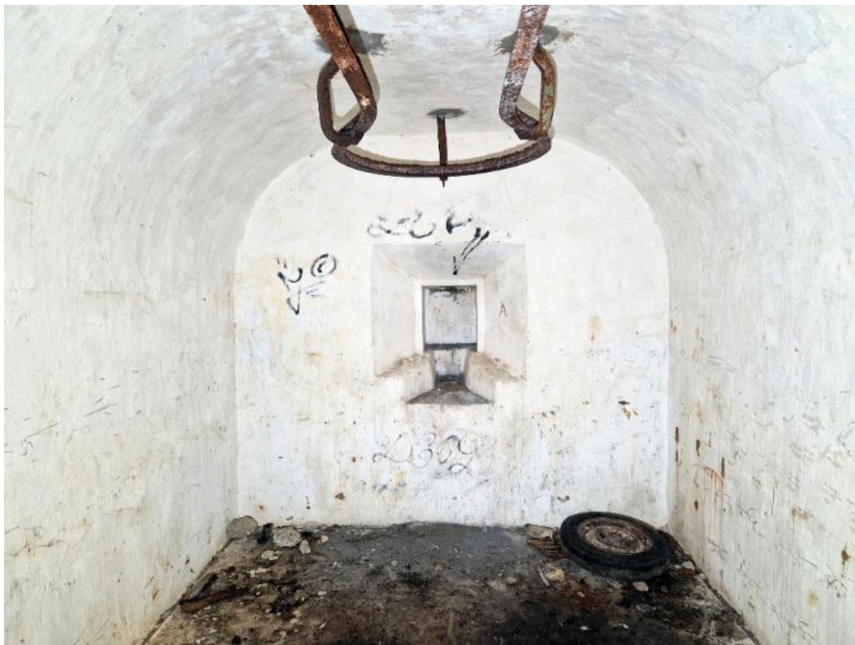
Vue intérieure du magasin à munitions : extrémité est avec créneau à lampe, fixations et rail pour la manutention des obus via un palan
