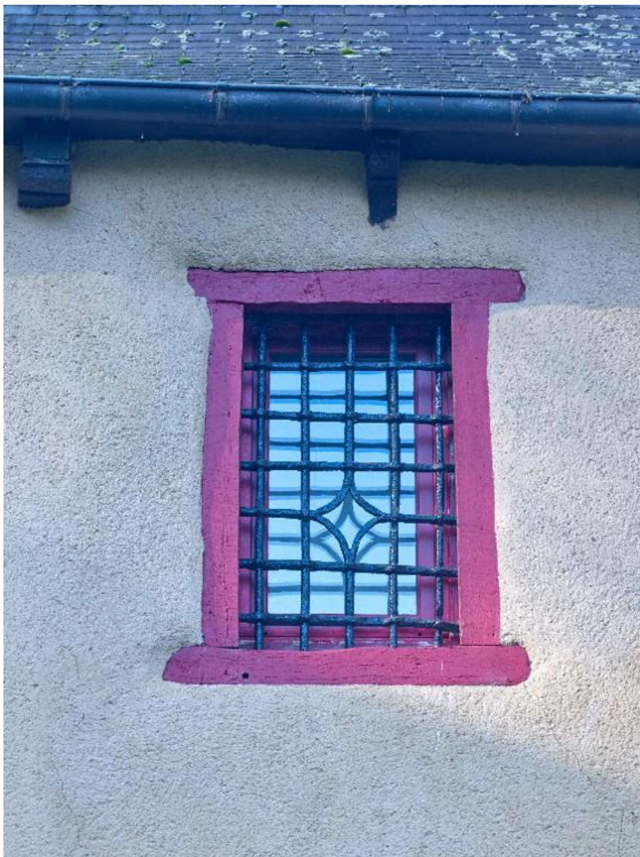
Logis principal. Façade est. Etage. Fenêtre grillagée de la chambre
