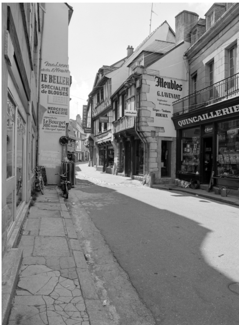
Rue du fil, vue générale.
