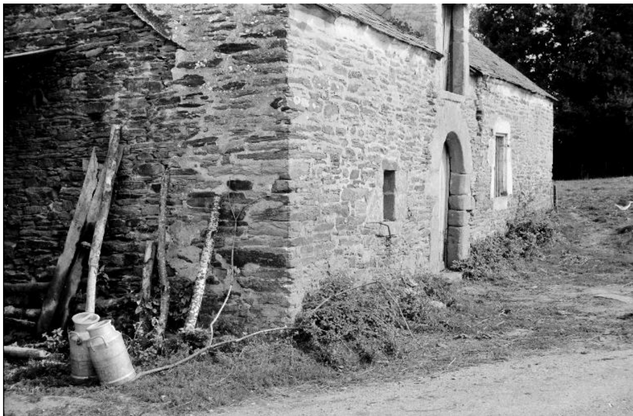
Ferme 57 (état en 1969)
