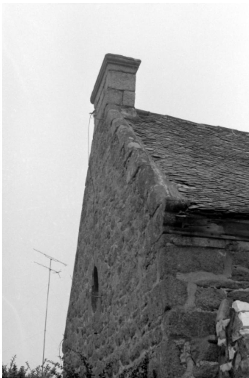
Mur-pignon ouest (cliché S. Laffiché, pré-inventaire, 1973)
