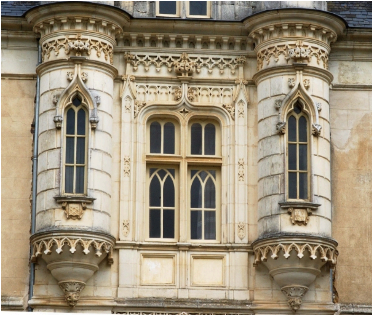
Château, détail des parties hautes, tourelles en encorbellement
