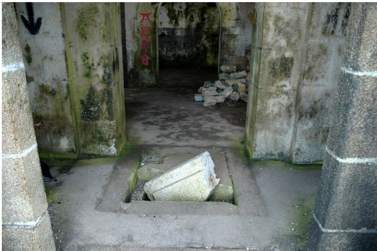
Vue du réduit de batterie de côte de Loqueltas, passage de l'entrée et citerne (sous-sol)
