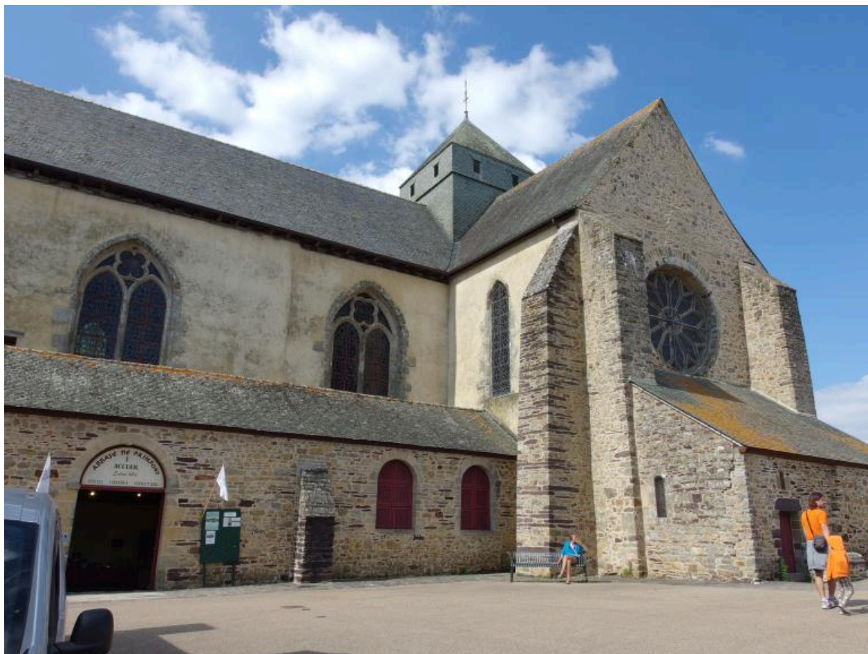
Vue partielle sud-ouest de l'abbaye 2018
