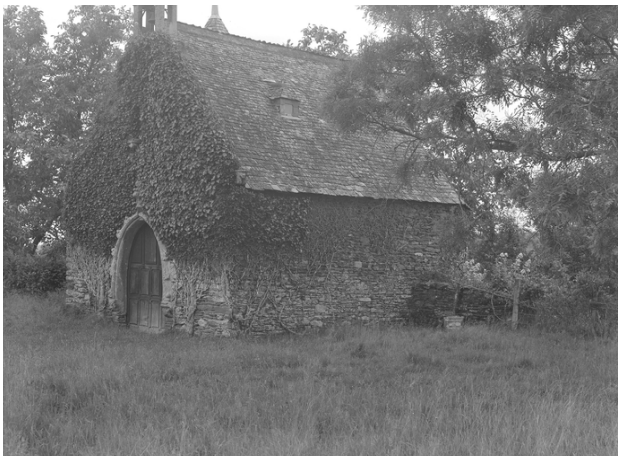
Chapelle Saint-André : vue générale sud-ouest
