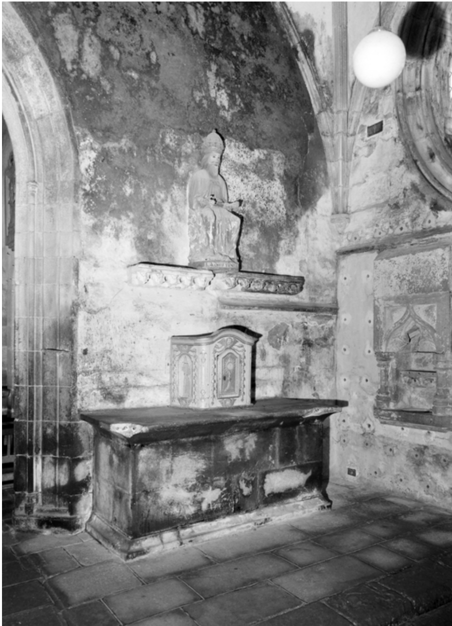
Autel du bras sud, vue générale.
