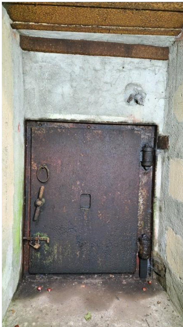
Vue de la porte blindée du bunker-citerne
