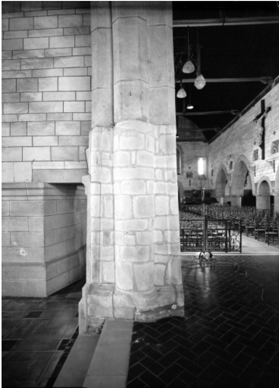
Intérieur, nef, pile de la croisée : vue générale.
