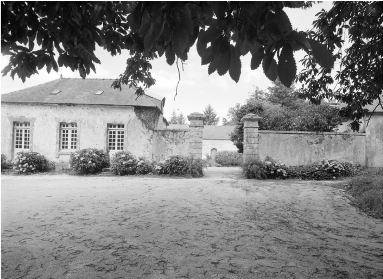
Communs, extérieur : vue prise du sud-ouest
