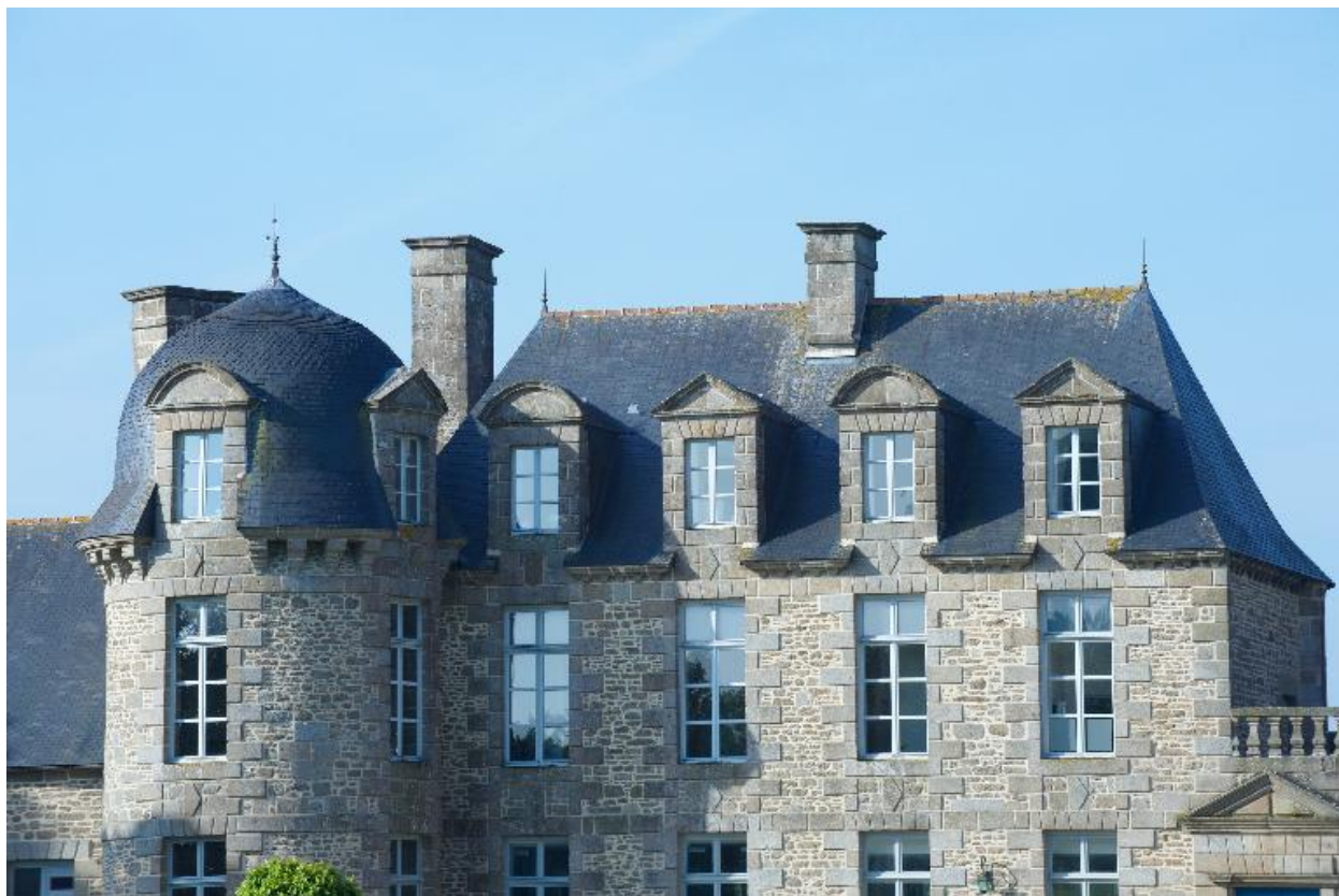
Partie supérieure du bâtiment principal
