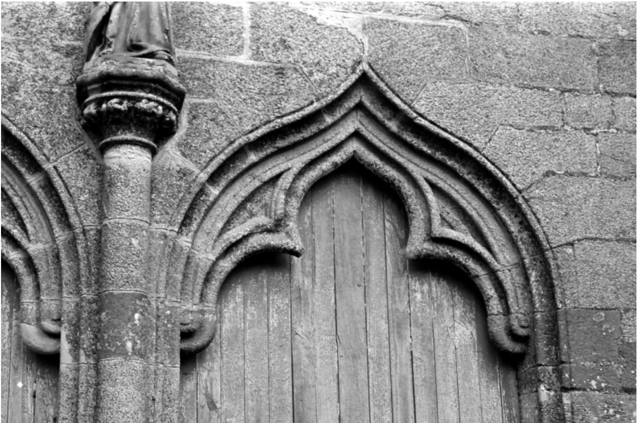
Porche ouest, détail d'une des portes
