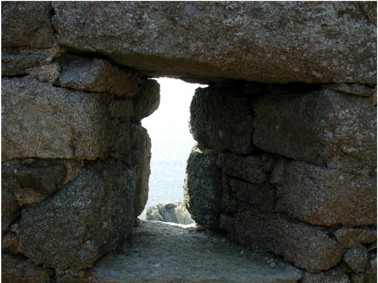
Vue de l'un des créneaux de tir (état en 2002)
