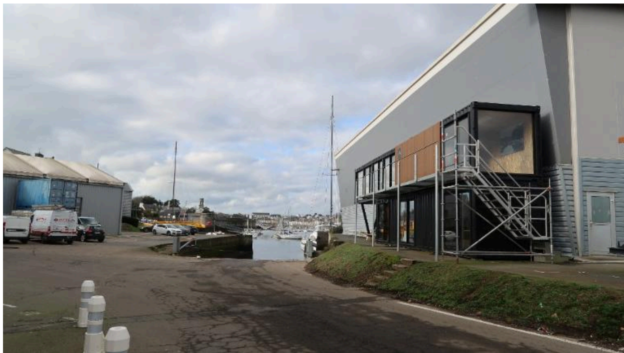
Aire de réparation navale : anse du Roudouic
