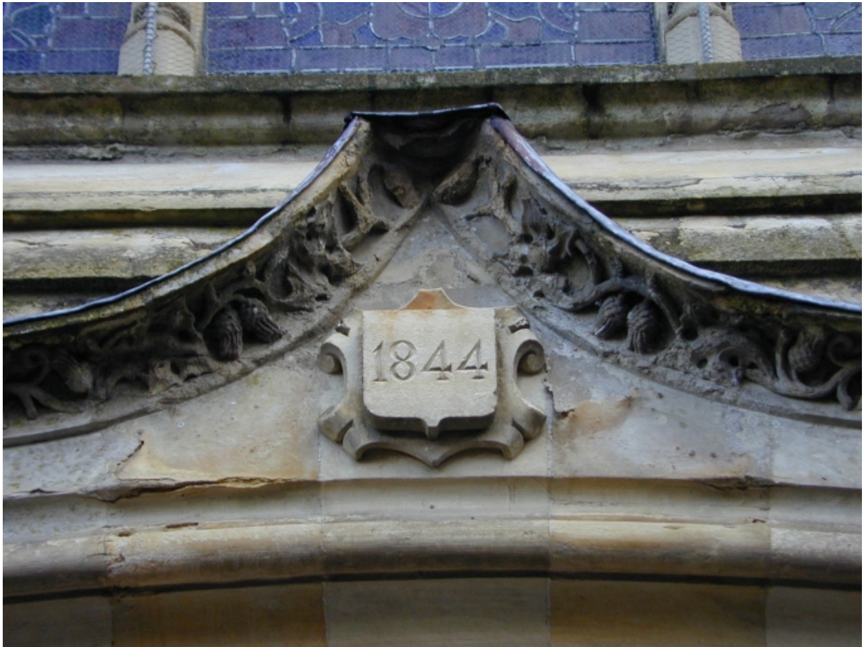
Façade ouest, portail, détail, date de 1844 gravée sur la clef
