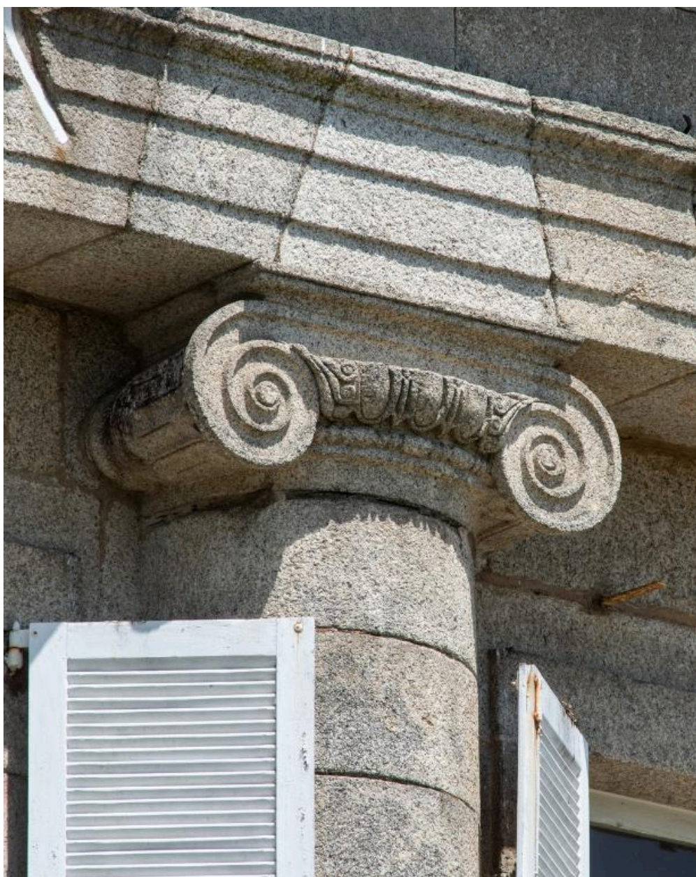
Chapiteau ionique de la façade principale
