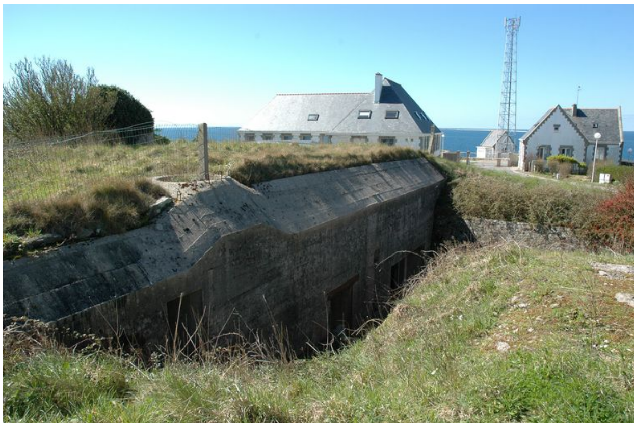
Vue de l'ensemble fortifié de la pointe du Renard : abri de type V 256 pour machine
