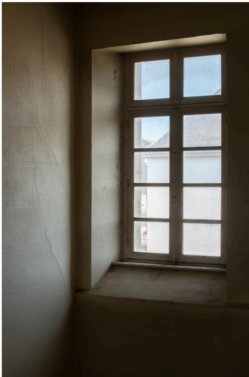
Fenêtre au-dessus de l'escalier
