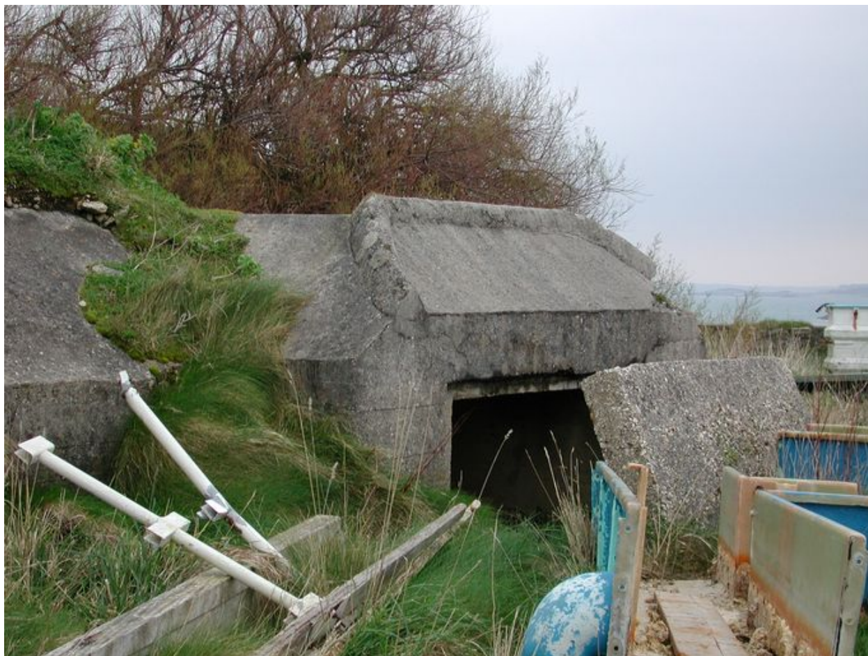
Vue générale de l'entrée de la soute protégé par un mur en béton armé (état en 2002)
