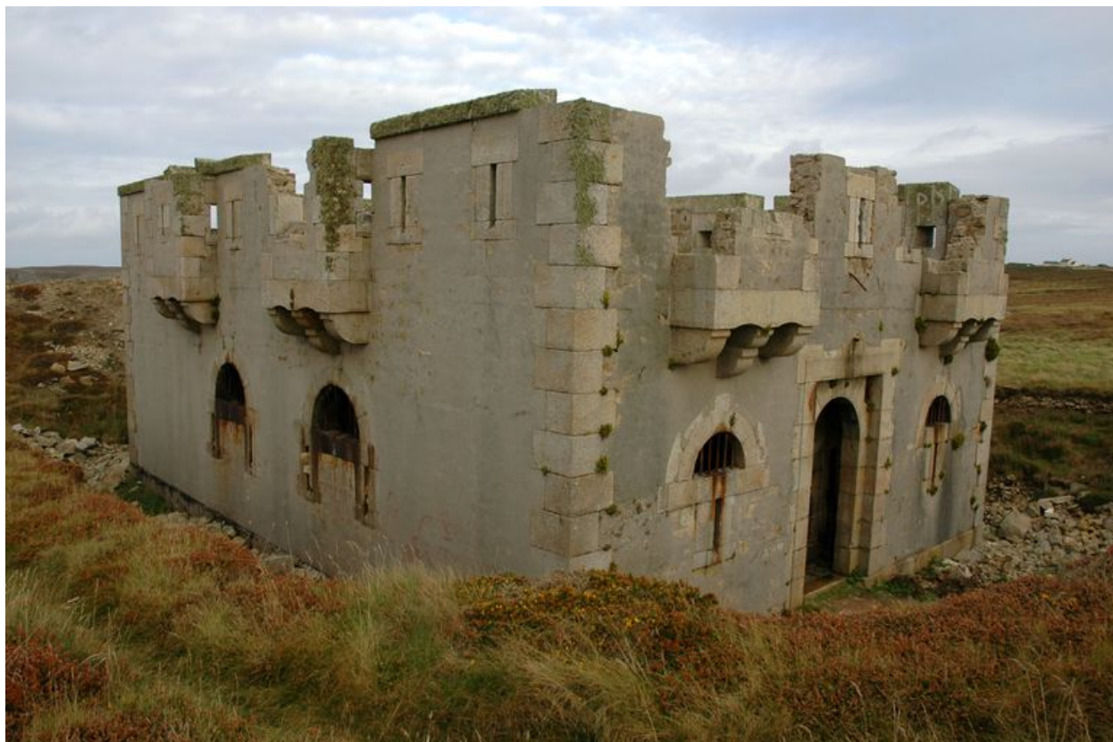
Vue du réduit de batterie de côte de Calgrac'h, angle sud-ouest
