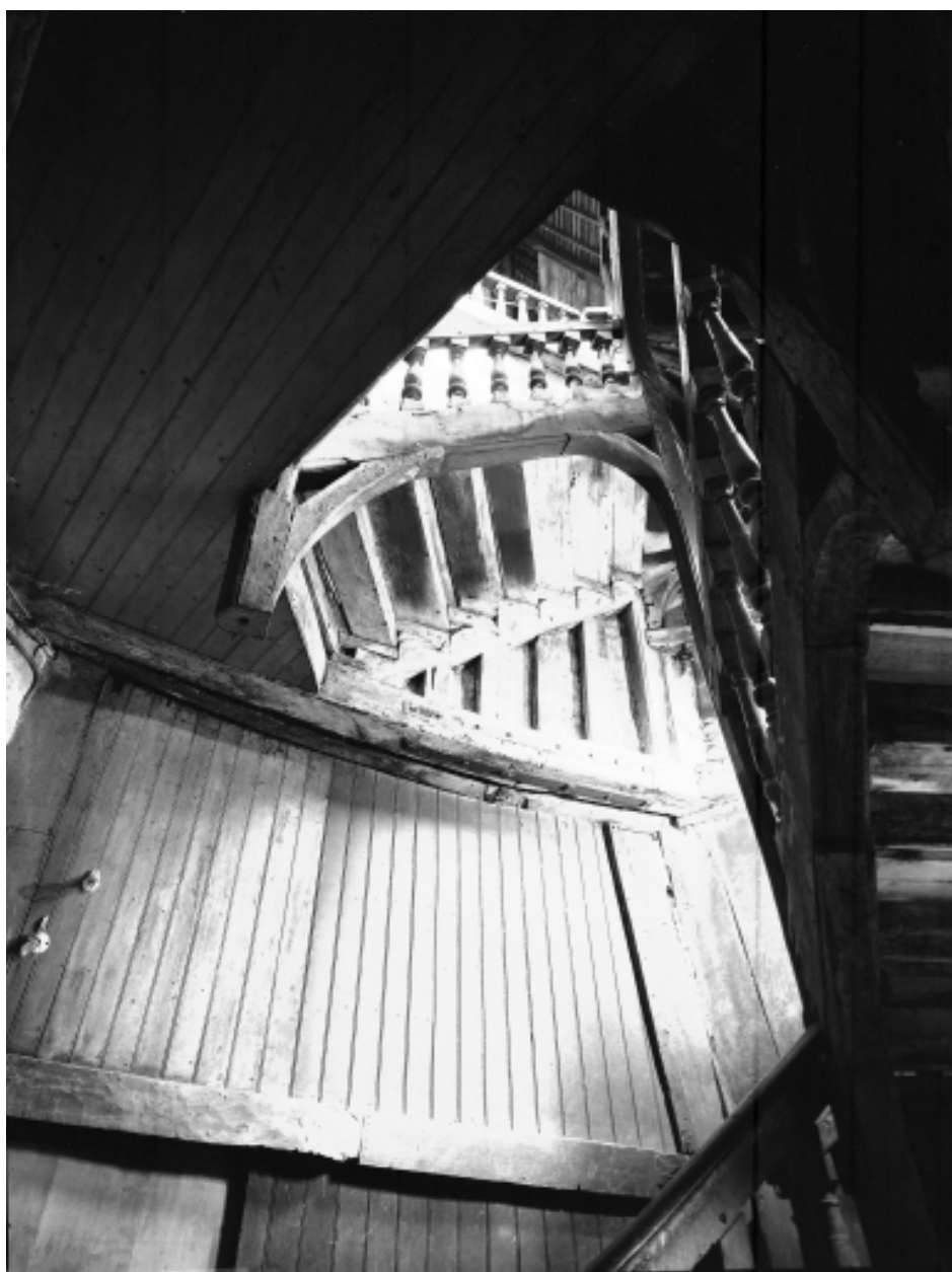
Escalier : vue du premier étage
