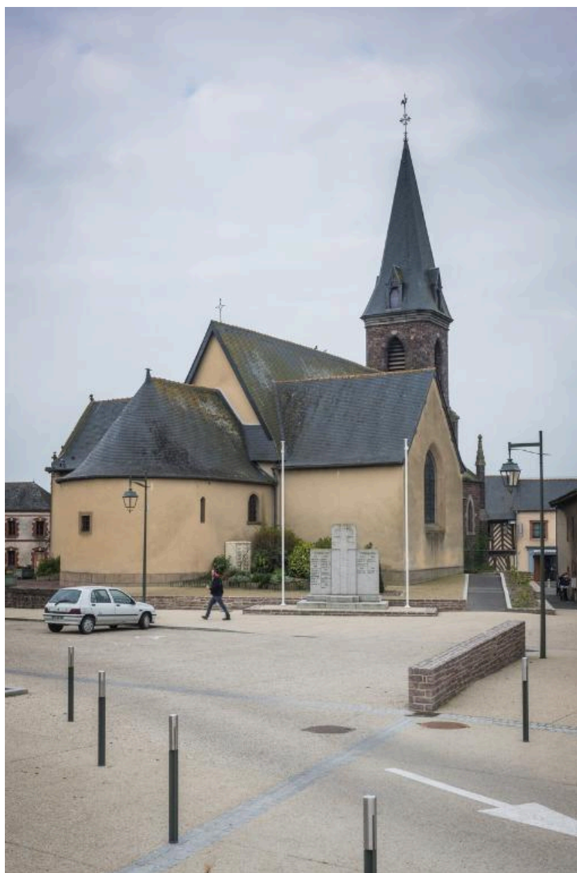
Vue générale de la façade Est
