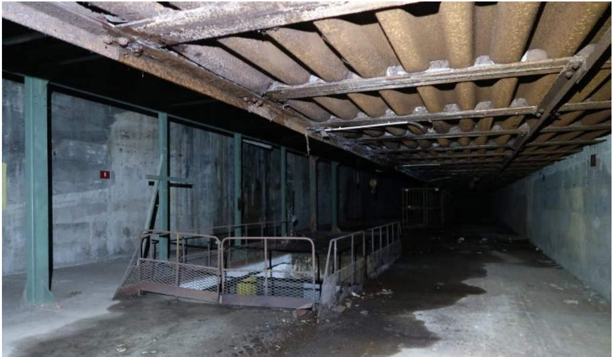
Vue de l'extension nord-ouest : dessous du débord de la dalle de couverture du bunker Keroman III, plaques nervurées
