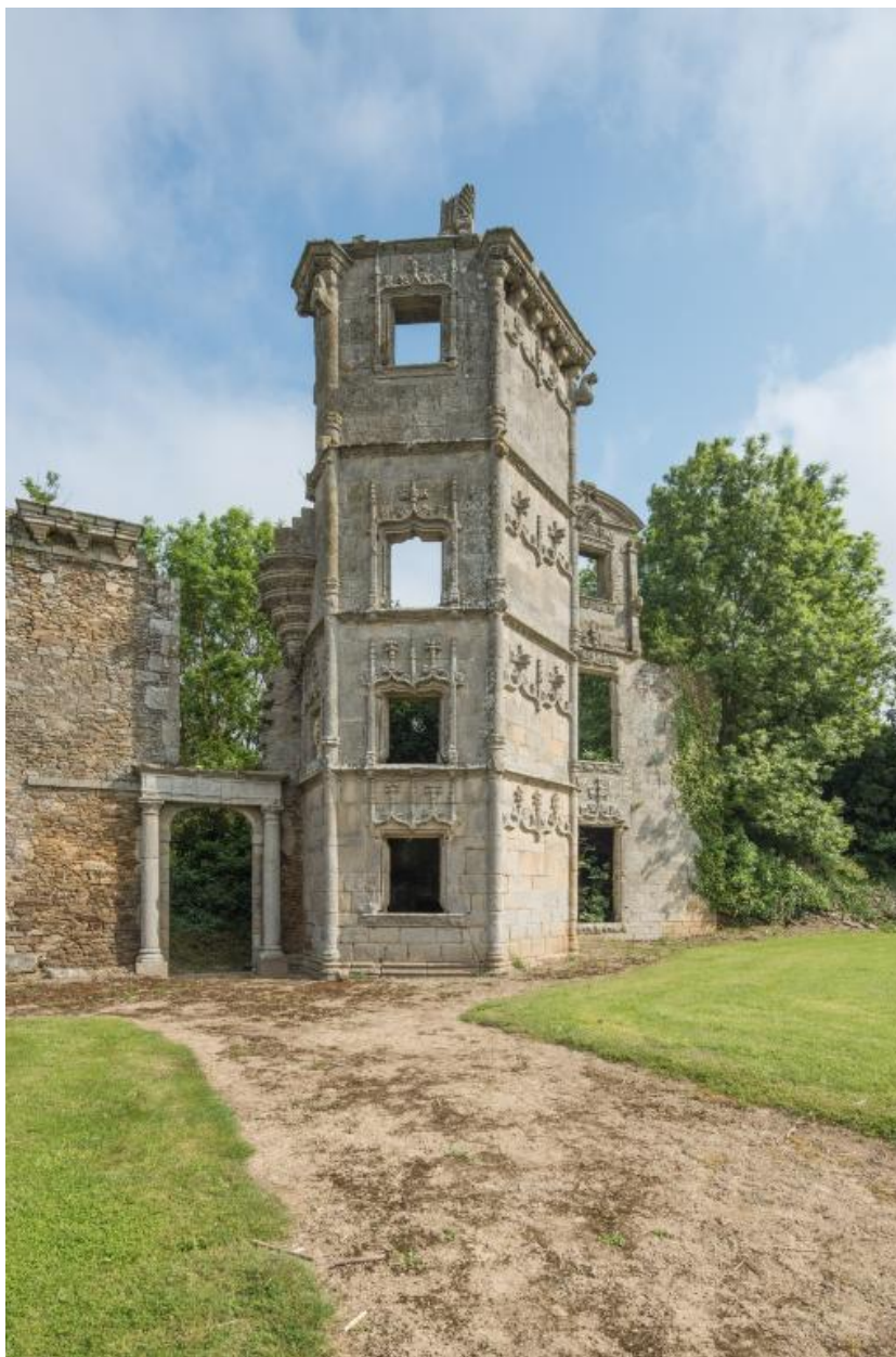
Le château : La tour d'escalier
