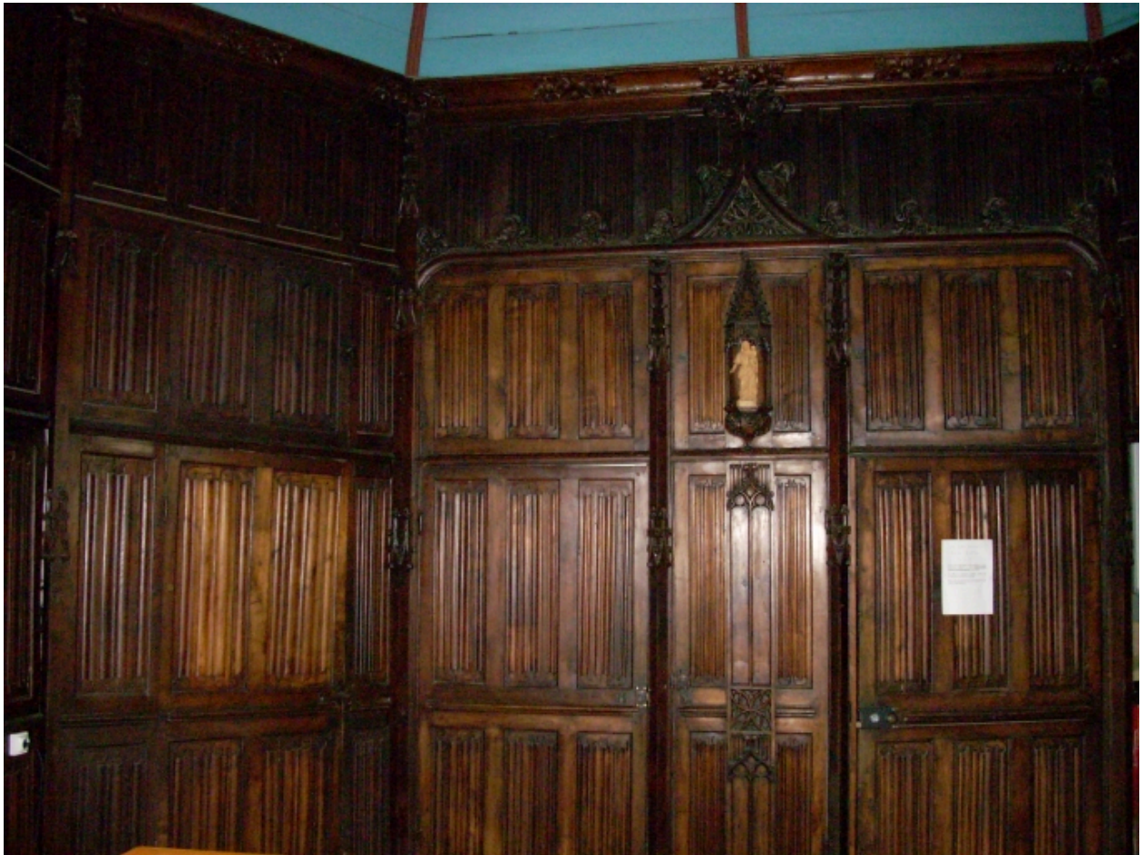
Plonévez-du-Faou, église paroissiale Saint-Pierre : intérieur de la sacristie
