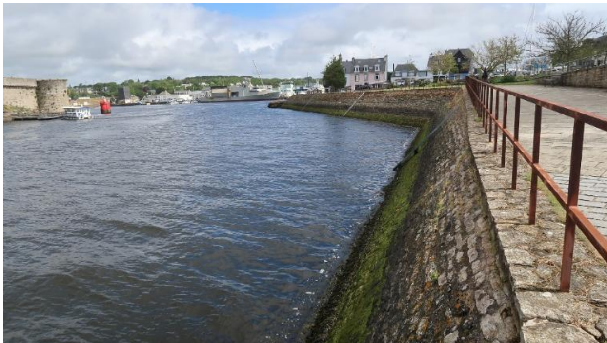
Le perré Duquesne : soutènement du terre-plein créé au 20e siècle
