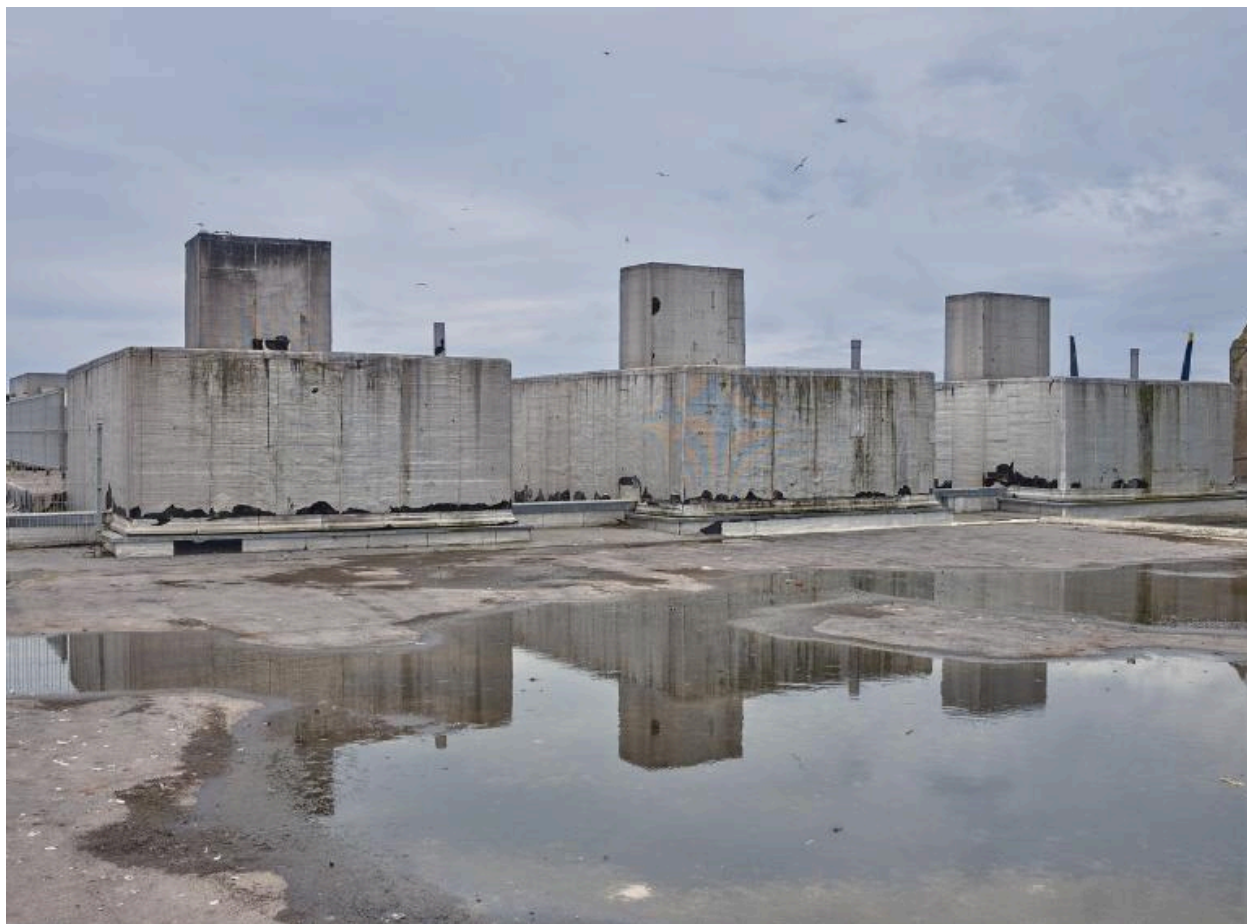
Vue générale des trois cheminées de la chaufferie depuis la dalle de couverture du bunker KI
