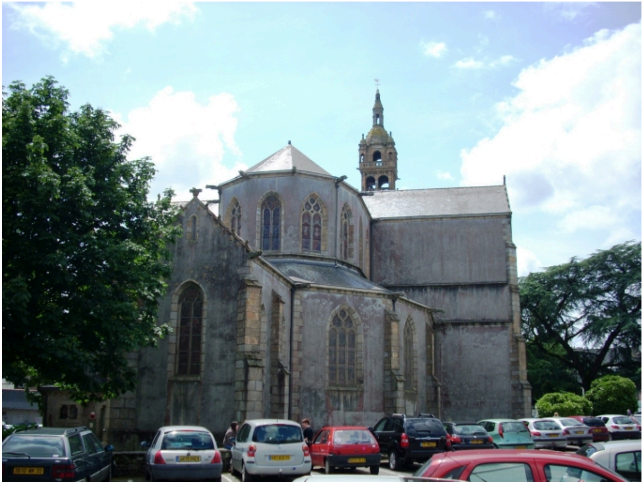
Landerneau, église Saint-Houardon : vue générale nord-est
