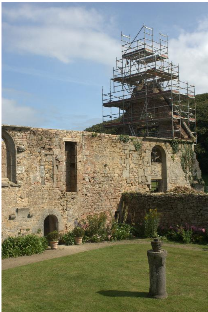
Vue de détail du mur sud de la chapelle
