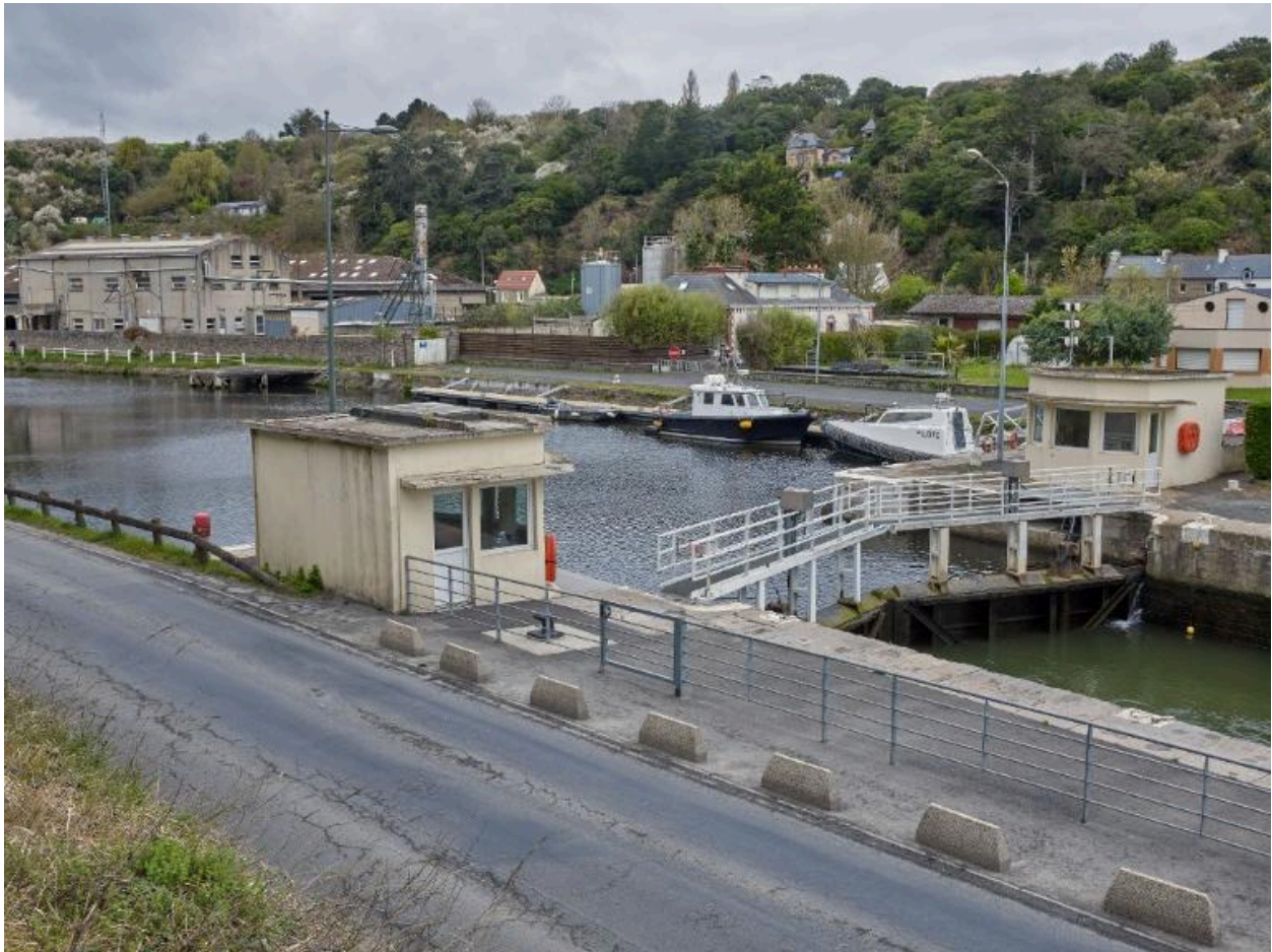
Les postes de commande amont de l'écluse, le quai des pilotines et l'île sèche et l'ancienne usine de bitume
