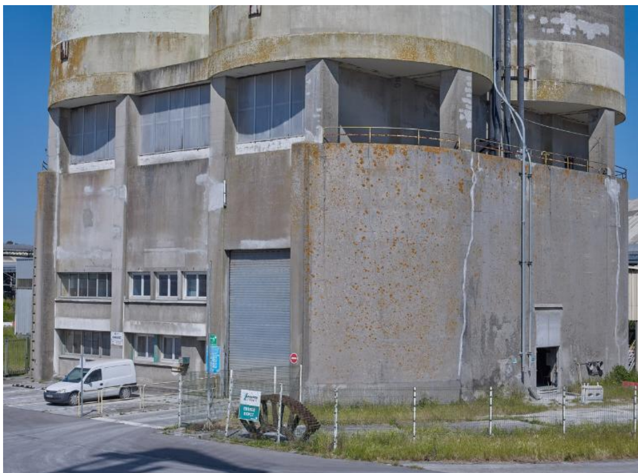
Silos à ciment en béton de la cimenterie Lafarge
