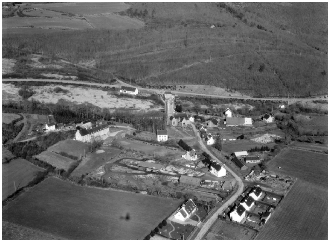
Vue de situation prise du sud
