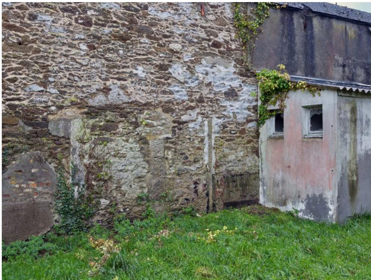
Vue de détail du mur de clôture à l'est : porte murée débouchant rue de Pontaniou. A droite, bâtiment accolé au mur de clôture
