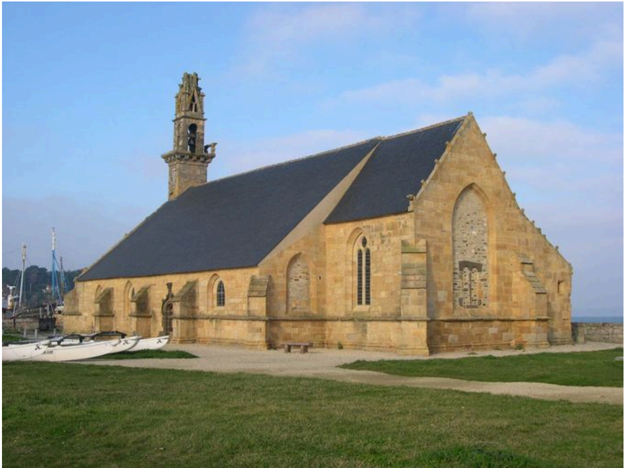
Elévations extérieures sud et est de la chapelle Notre-Dame-de-Rocamadour
